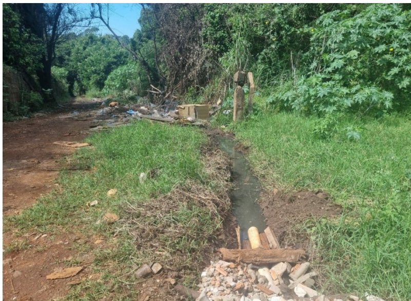
Figura 28. Lançamento de esgoto sanitário in natura pela ocupação irregular localizada próxima ao "Campo do Cruzeiro" dentro dos limites do PEBAR. Fonte: PMRP, 2025.
