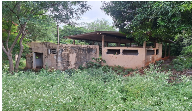
Figura 23. Edificação remanescente do viveiro de mudas. Fonte: PMRP, 2025.
