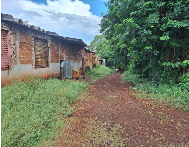
Figura 22. Ocupação irregular para instalação de moradias dentro dos limites do PEBAR área do Horto. Fonte: PMRP, 2025.
